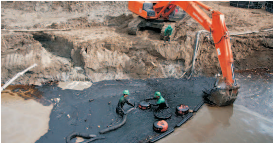
Aspecto de la recolección del crudo derramado sobre el Río Pamplonita. Foto Juan Pablo Cohen / La Opinión
